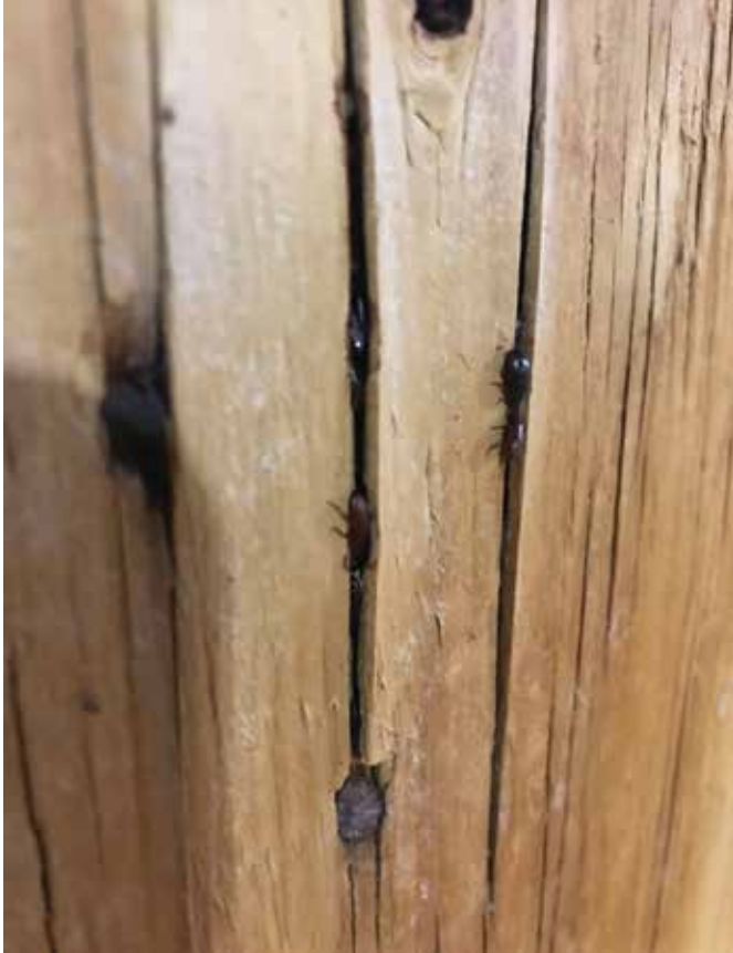
Ténébrions traversant des planches de bois fendues pour atteindre l'isolation
