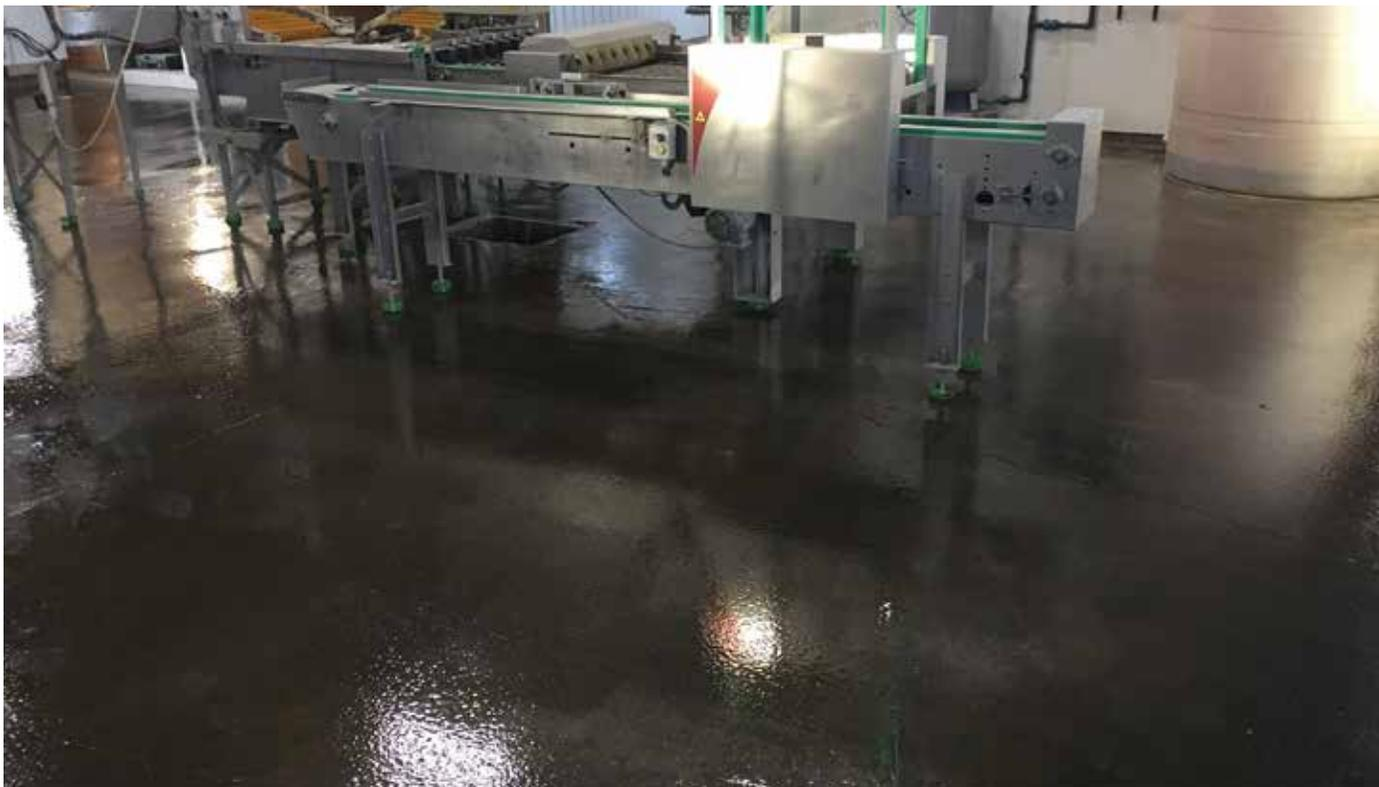
*Application d'époxy sur du béton*
