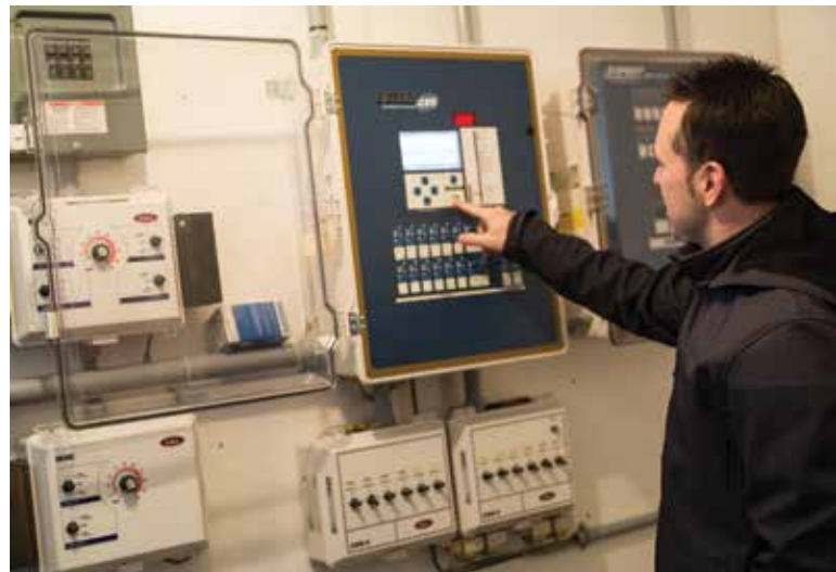
Nicolas vérifie le panneau de contrôle relié à la température et à la ventilation.
