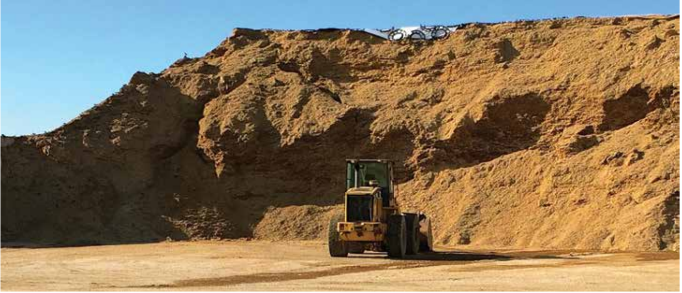
Une face de silo meule partiellement affaissée et sur le point de s'affaisser à nouveau
