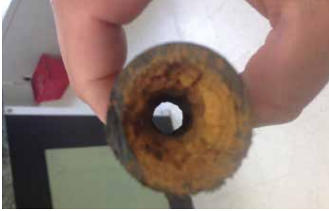
Conduite d'eau avec Biofilm
