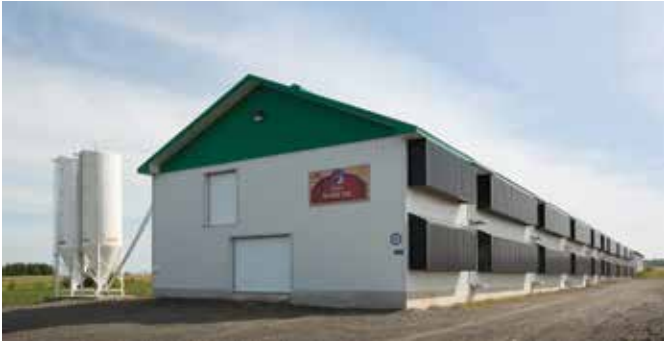
Le poulailler principal muni d'entrées d'air solaires après l'agrandissement
